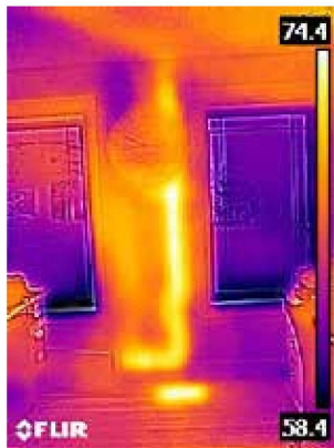
墙壁中的热水排水管
