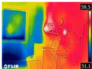
保温性能差的外墙
