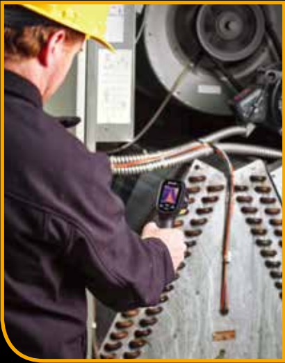
暖通空调(HVAC)检查
